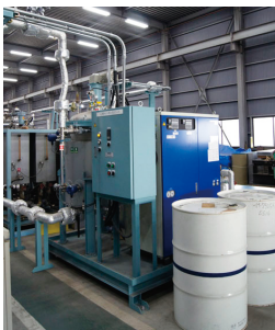
壁用パネル(ウレタン) 製造ライン
