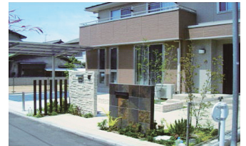
民間土木工事
