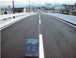
福岡三谷線道路整備工事
