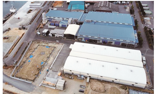
丸亀第二工場（新工場建設中）
