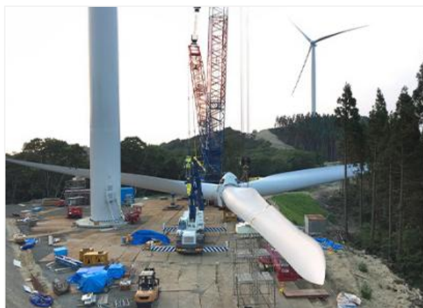
風力発電所建設工事
