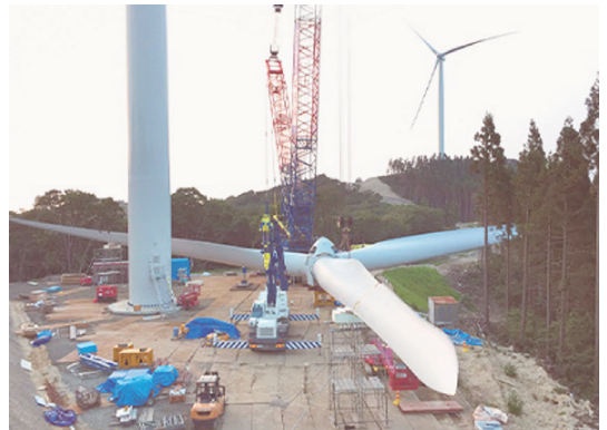
風力発電所建設工事
